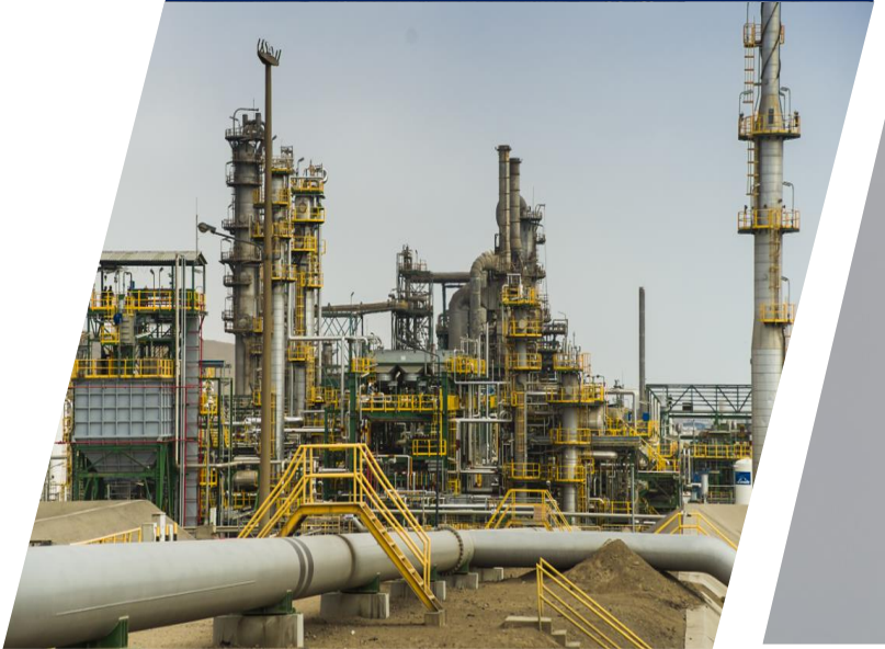
Fin de Construcción
