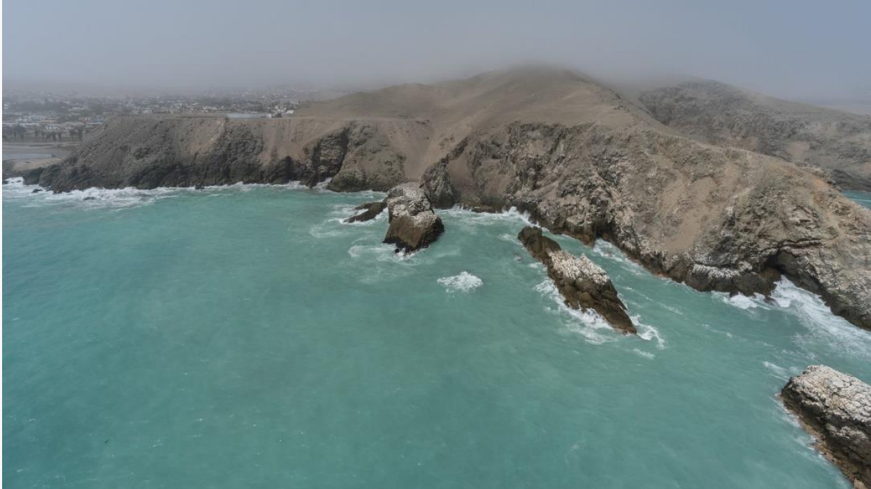
Figura 1. Vista área de una de las áreas afectadas donde ya se culminaron las acciones de primera respuesta.
