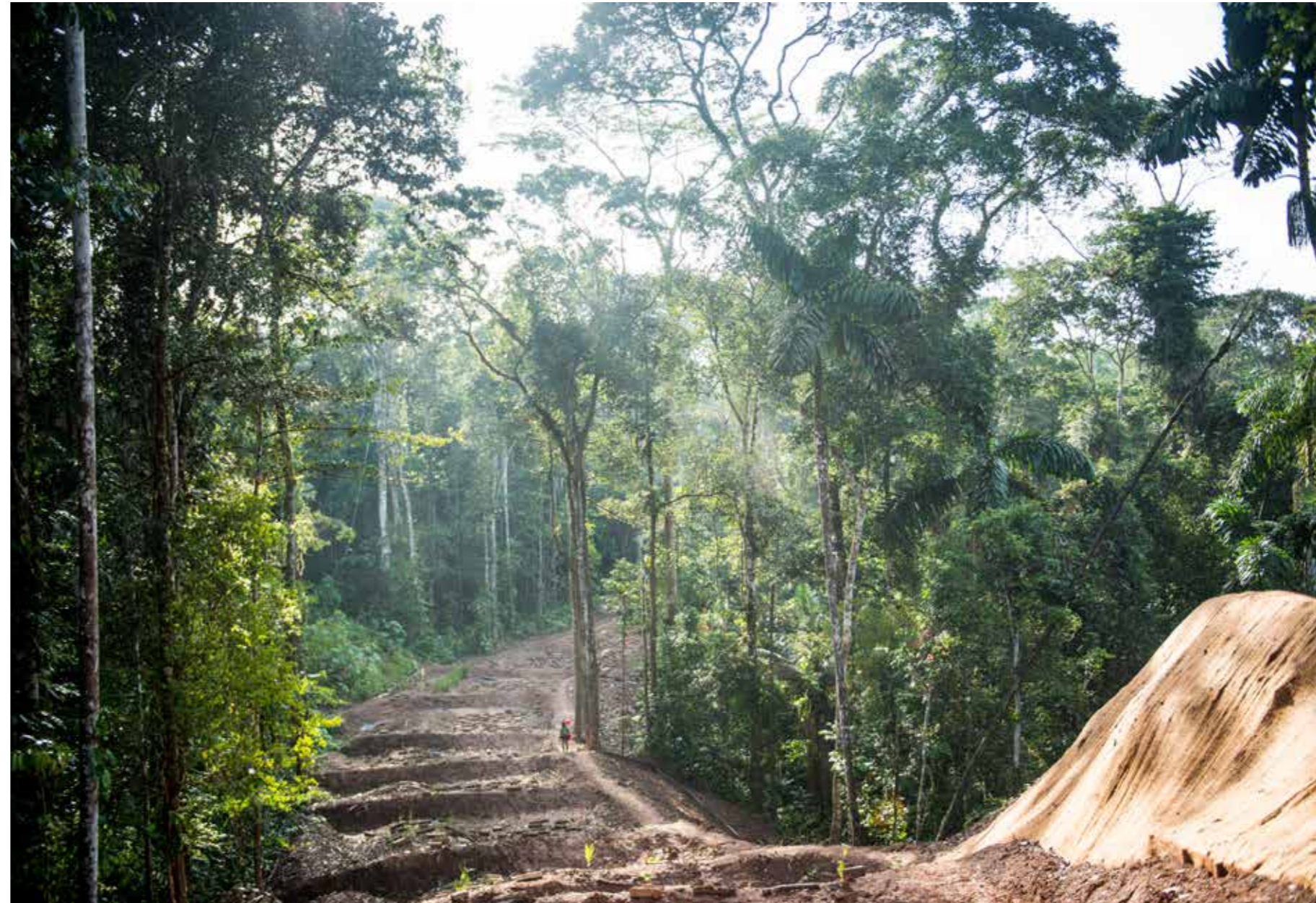
Figura 5. Esquema de mitigación de impactos a través de la reducción del DdV durante la construcción del gasoducto Sagari
